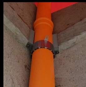
MONTAŻ KOŁNIERZA NA RURZE W NAROZNIKU POMIESZCZEN
