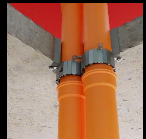
KOŁNIERZE NA RURACH PROWADZONYCH BLISKO SIEBIE
